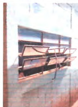
VENTANA, SUSTITUCION DE VENTANAS
