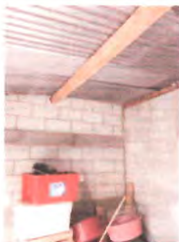
ESTRUCTURA Y CUBIERTA DE TECHO, SUSTITUCION
