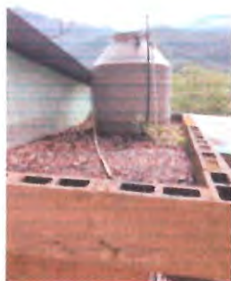
IMPERMEABILIZACIÓN DE LOSA, TRABAJO CORRECTIVOS EN LOSA
