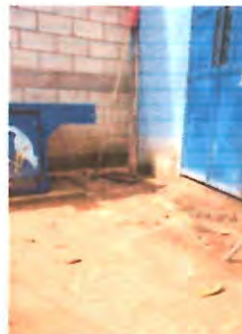
LOSA DE PATIO, REPARACION LOSA DE PATIO DE COCINA
